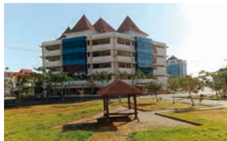
Multifunkční budova ve středu kampusu UTM. Je určená k výstavám, sportu, je tam i knihovna a IT středisko.
